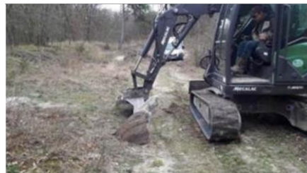
Pelle munie d'un godet prélevant une dalle de végétation
