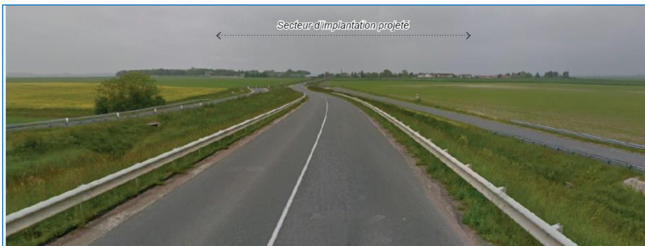
Perception du site éolien au sud de Bordeaux en Gâtinais à partir du pont sur l'autoroute A 19 (départementale 94).
