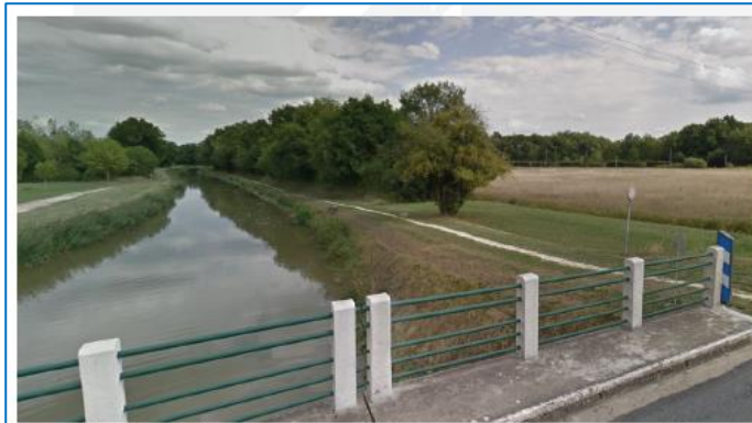
Canal d'Orléans à Presnoy à partir de la départementale 38
