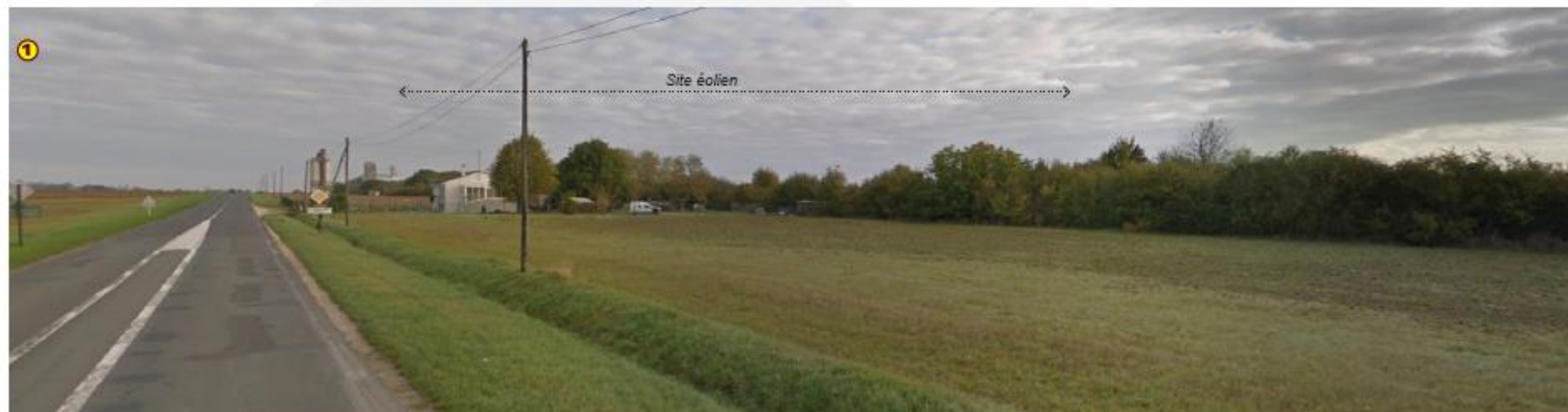
Site perçu à partir de la départementale 975 à Auxy. Une bande boisée qui accompagne la voie de chemin de fer est localisée en avant-plan. Le projet éolien sera perceptible derrière les arbres.
