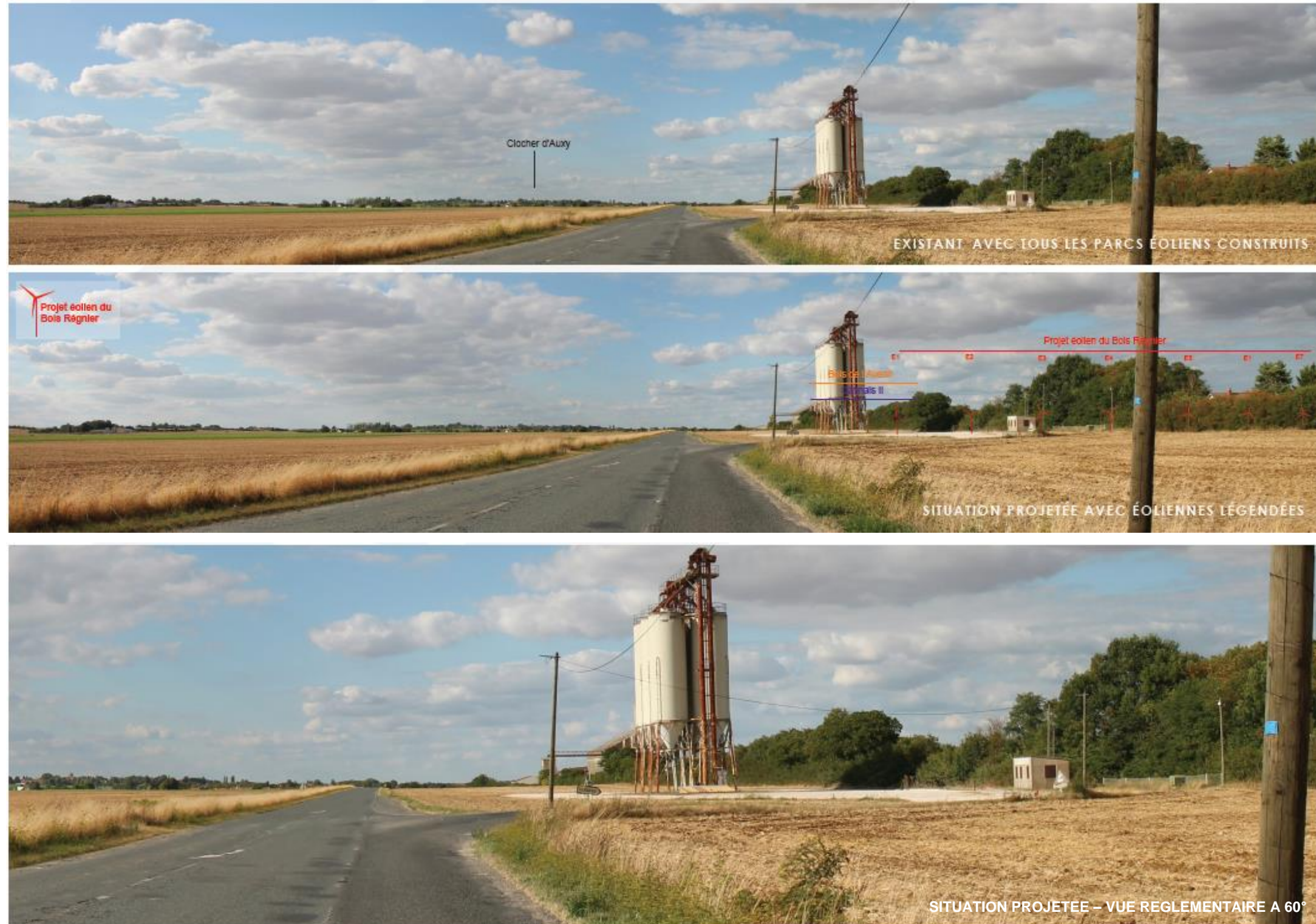
Figure 104 : Vue à partir de la départementale 948 - Commune d'Auxy
