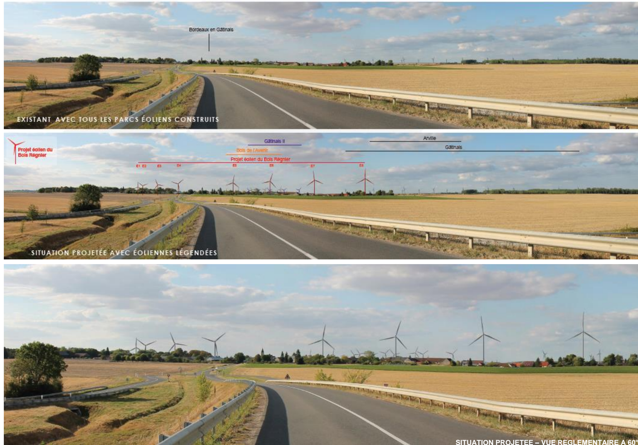
Figure 92 : Vue à partir du pont de l'autoroute A 19 - Commune de Corbeilles
